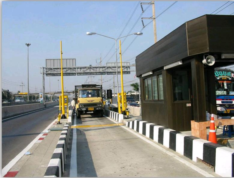
**Figura 5 - Balanzas Fijas para Pesaje Dinámico/Estático por Ejes**
