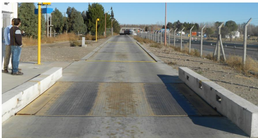
**Figuras 7 y 8 - Conjunto Balanzas Fijas para Pesaje Estático por Tándem y Peso Total**
