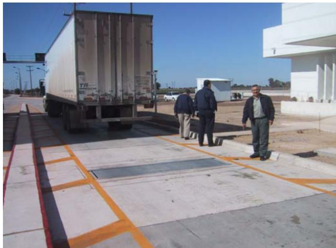
**Figura 4 - Balanzas Fijas para Pesaje Estático por Ejes**
