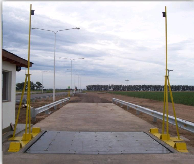
**Figura 6 - Balanzas Fijas para Pesaje Estático por Tándem (Grupo de ejes)**
