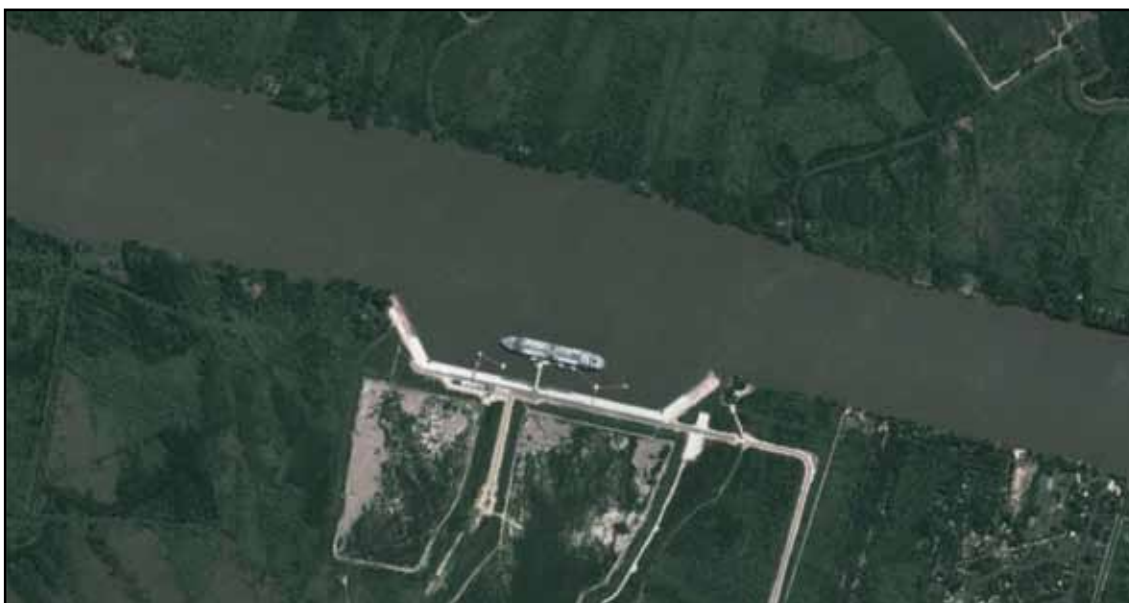
Figura 3.7: Escobar, Terminal LNG
