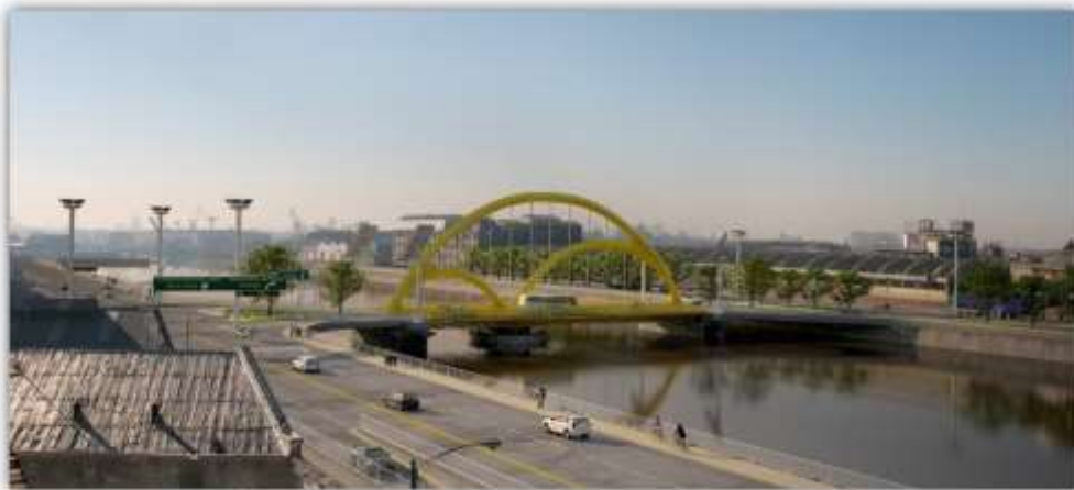
Puente Roca Patricios
