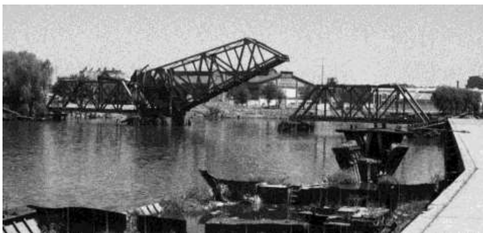
Figura 14: Vista del puente Bosh antes de la restauración (Clarín, 2018)
