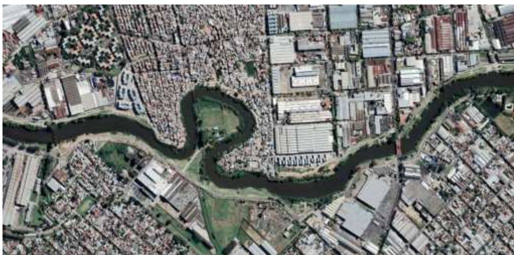
Figura 15: Obras requeridas: rectificación del meandro Ing. Brian
