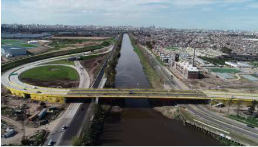
Puente Olímpico Ribera Sur
